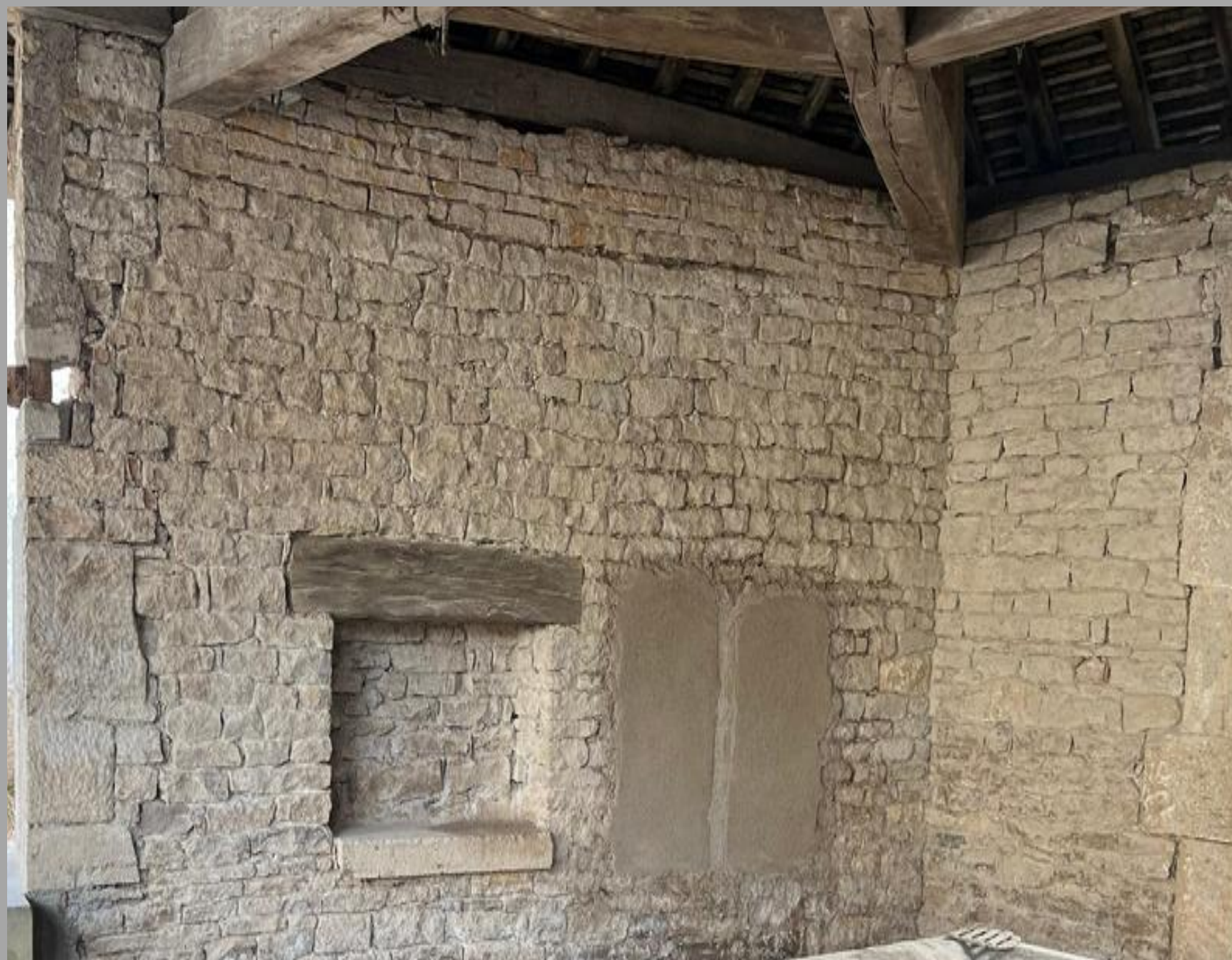
État existant avant restauration
