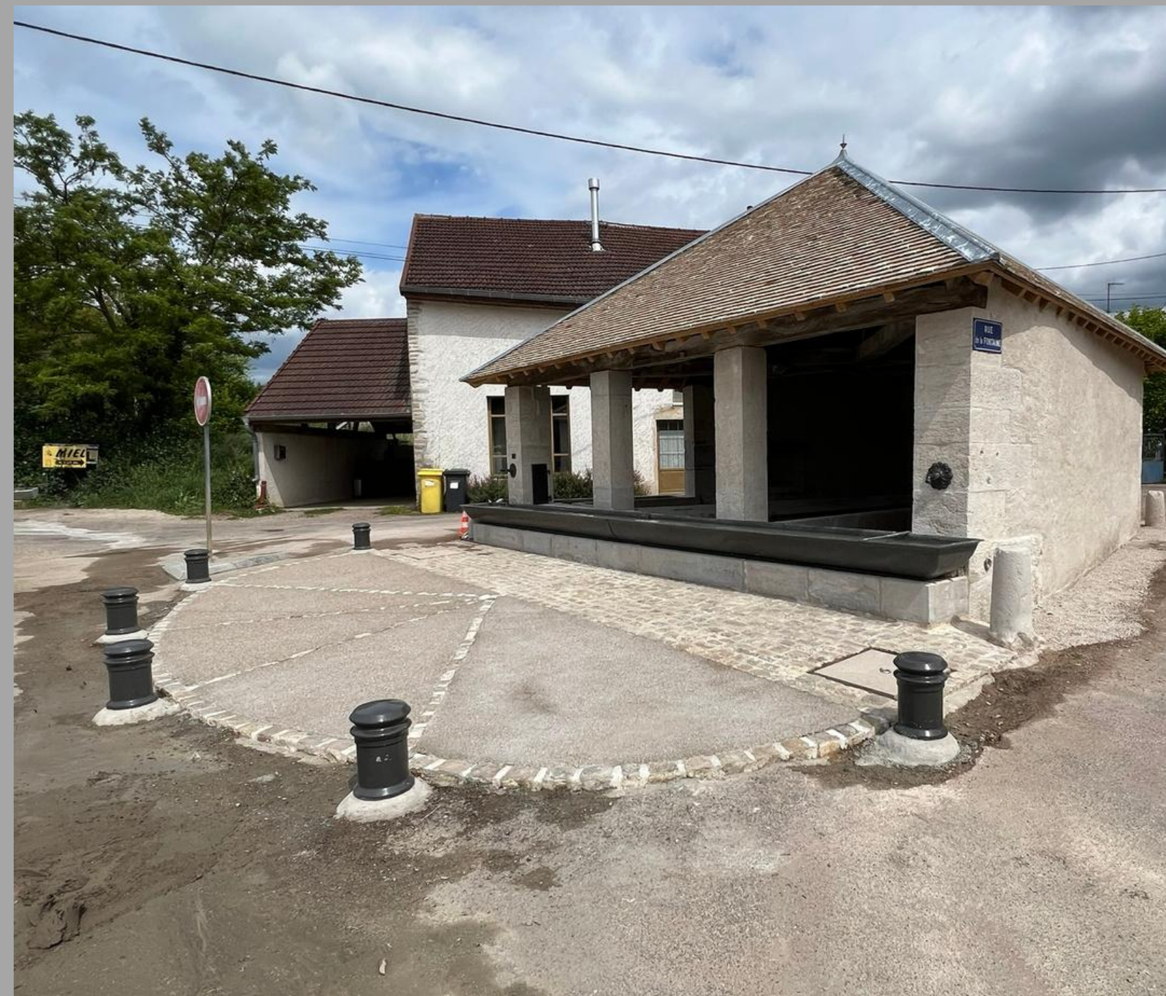
État du lavoir après restauration
