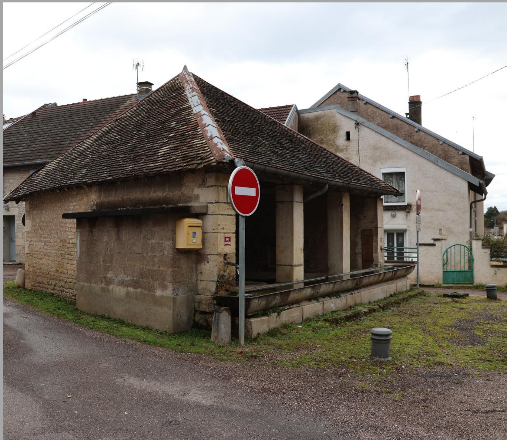
État du lavoir avant restauration
