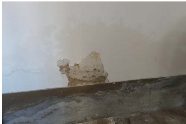
Photographie d'une remontée capillaire sur un soubassement paré de ciment
