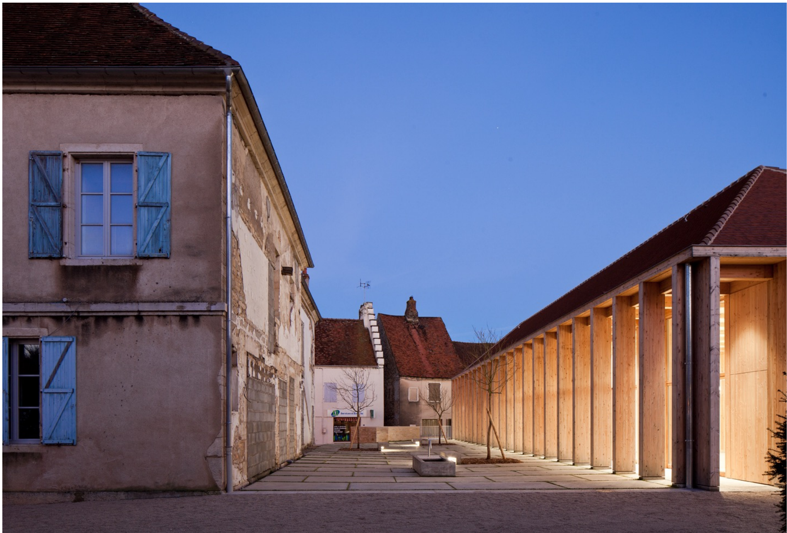
BQA | Restructuration du groupe scolaire de Pesmes | 2013
