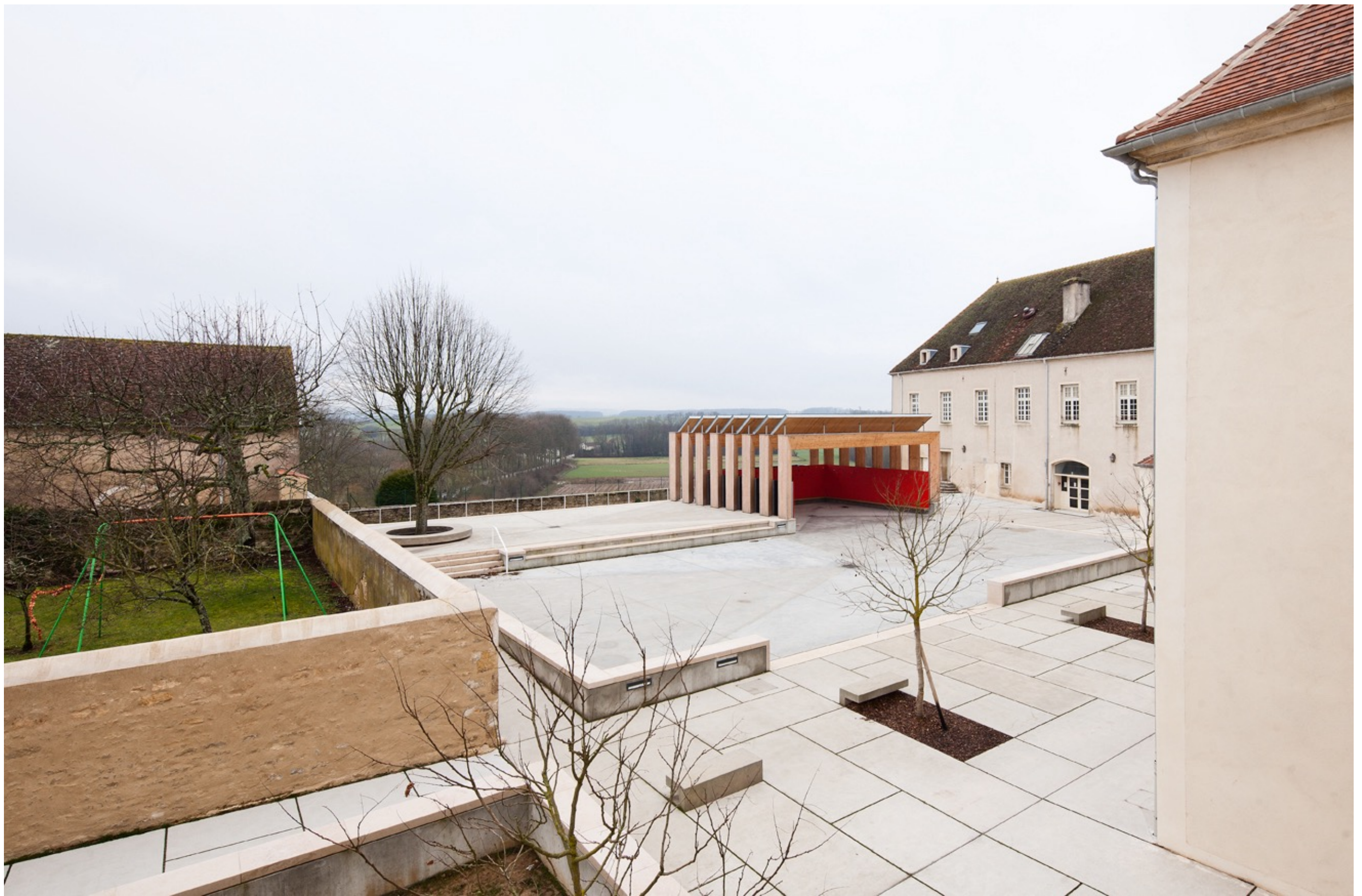
BQA | Restructuration du groupe scolaire de Pesmes | 2013
