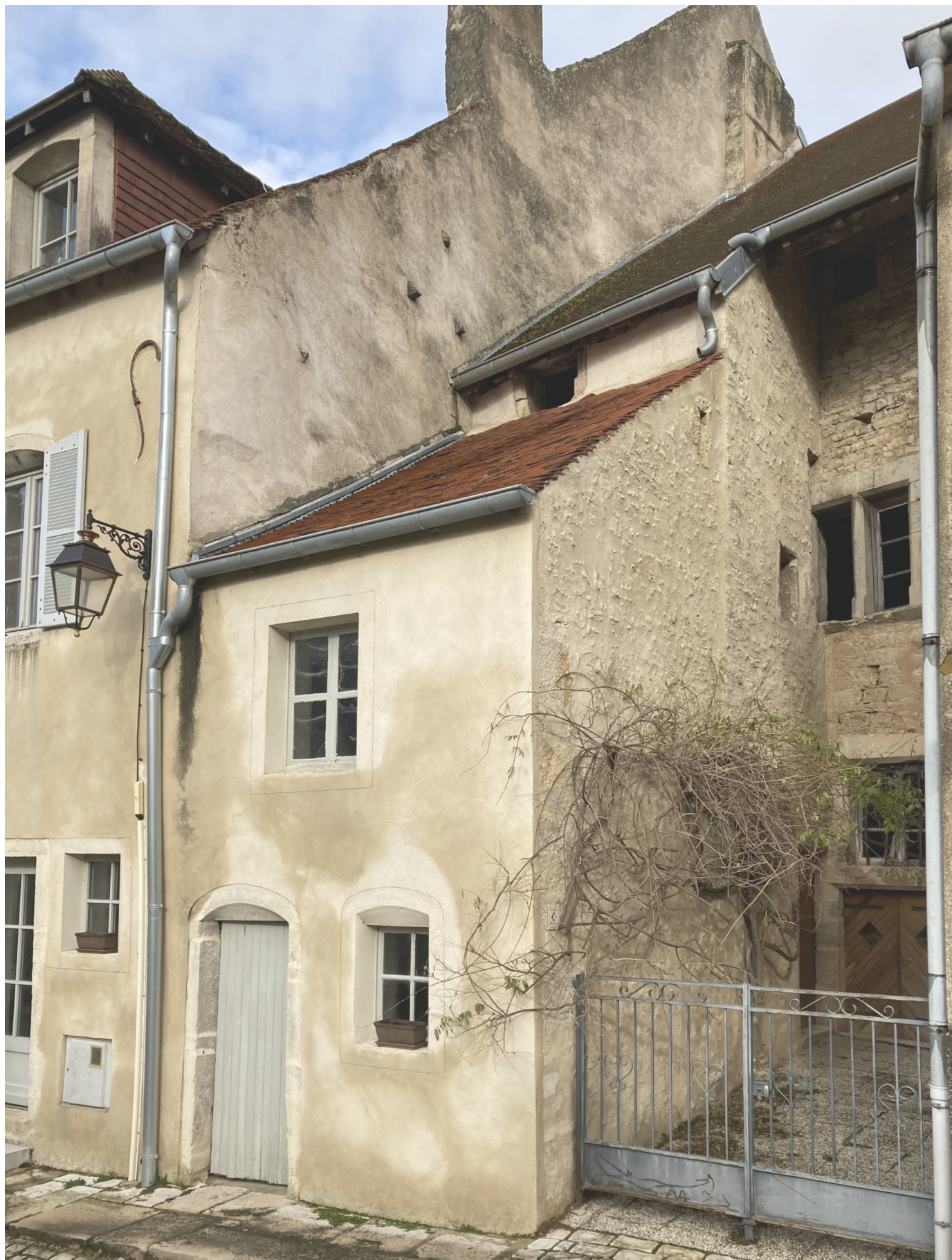
État existant avant travaux
