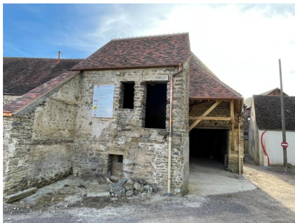
Grange de la ruelle de la Folie à Epoisses (Côte-d'Or)
