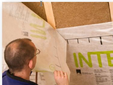
Chevauchement entre lés pour une bonne étanchéité Source : Proclima
