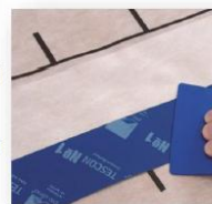
Utilisation d'un adhésif spécifique Source : Pro
