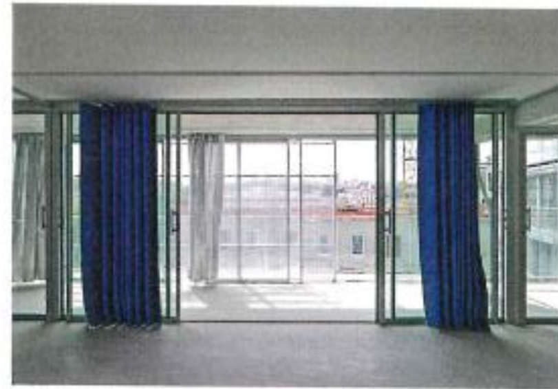
Association de rideaux thermiques et d'ombrage au jardin d'hiver d'un logement. Logements sociaux, quartier Ourcq-Jaurès, Paris 19 e , Anne Lacaton et Jean-Philippe Vassal, architectes, Siemp, maître d'ouvrage, 2014. © Philippe Ruault
