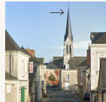
Vue actuelle de l'église Saint Sébastien de Bauné (49)
