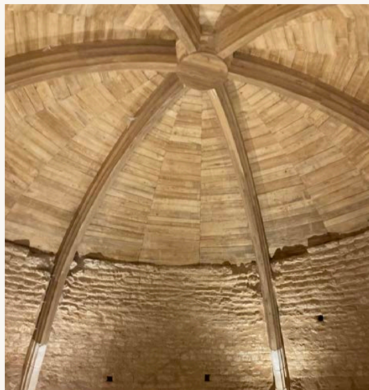
© Marie Béniguel, Architecte du Patrimoine, Tour du château de Montreui-Bonnin (86)
