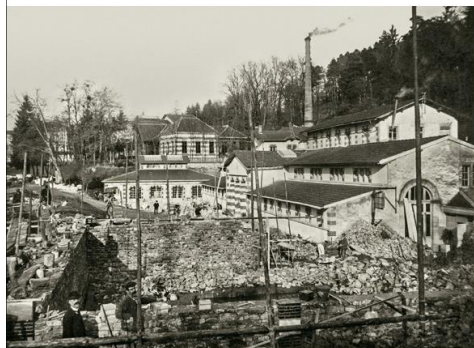
Saint-Honoré-les-Bains, chantier de construction de la deuxième piscine. Photographie, début du XX e siècle (archives du château de la Montagne, Saint-Honoré-les-Bains).
