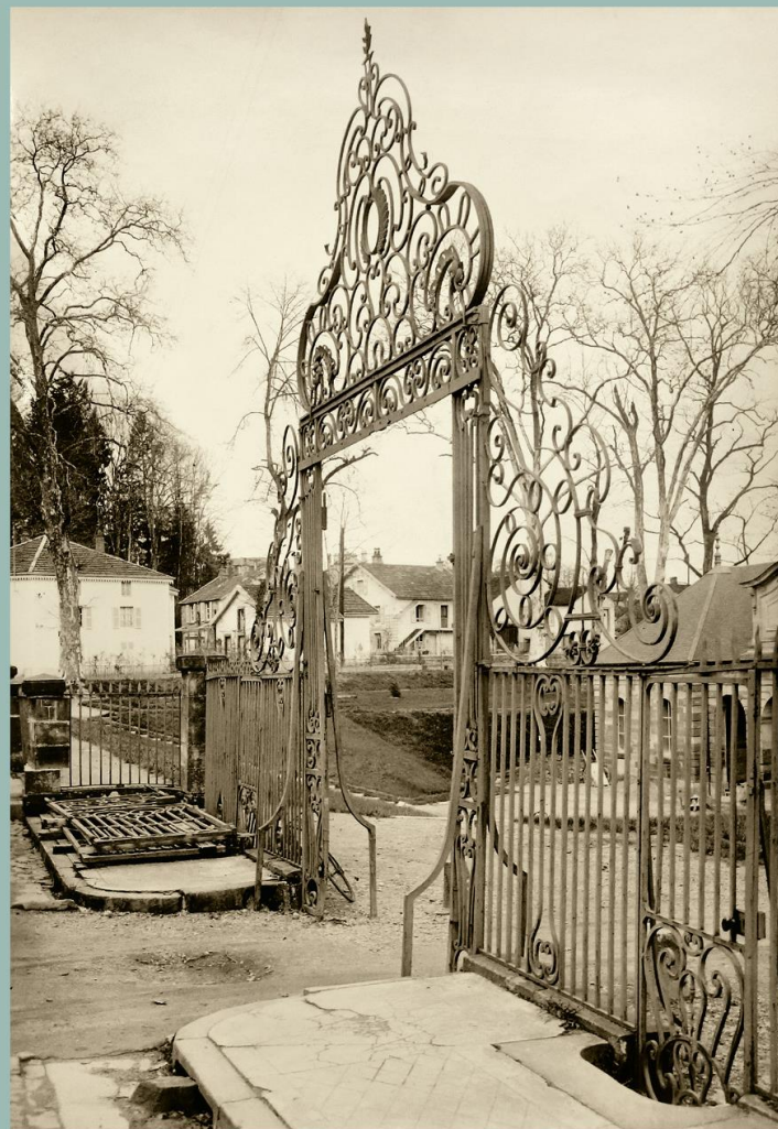
Luxeuil-les-Bains, grille de clôture de l'établissement thermal. Photographie, vers 1950 (Médiathèque du patrimoine et de la photographie). Lors d'une tournée d'inspection en 1954, André Saliez, adjoint à l'inspection générale des Monuments historiques, constate que la grille a été déposée, bien qu'elle soit comprise dans le classement du 5 septembre 1942. Vendue par la commune à la Ville de Nancy, elle est installée dans la cour du musée Lorrain où elle se trouve encore aujourd'hui.
