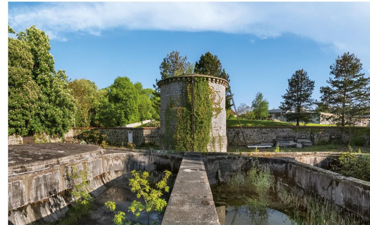
Bourbon-Lancy, château d'eau et bassins de refroidissement des bains de l'hôpital d'Aligre.
